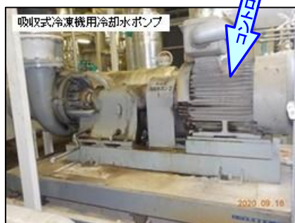
① 吸収式冷凍機用冷却水ポンプ
